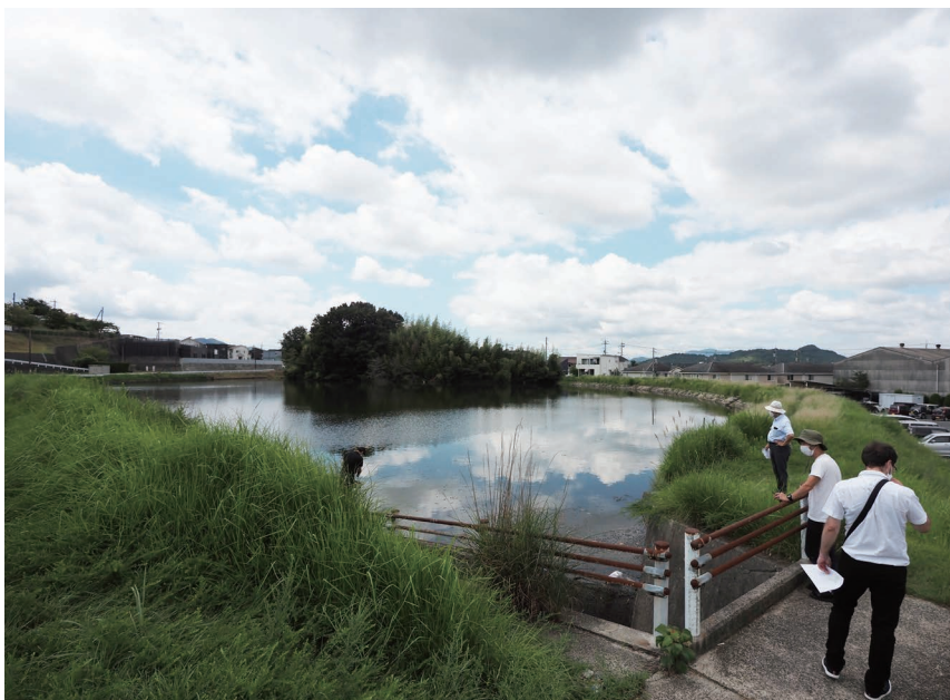
▲ 広島県東広島市におけるため池調査（2022年8月実施）
