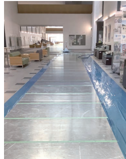
▲ 図2：養生された床
