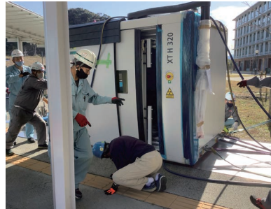
▲ 図3：ホバークラフトでの搬入作業
